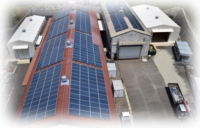
太陽光発電システムの導入
